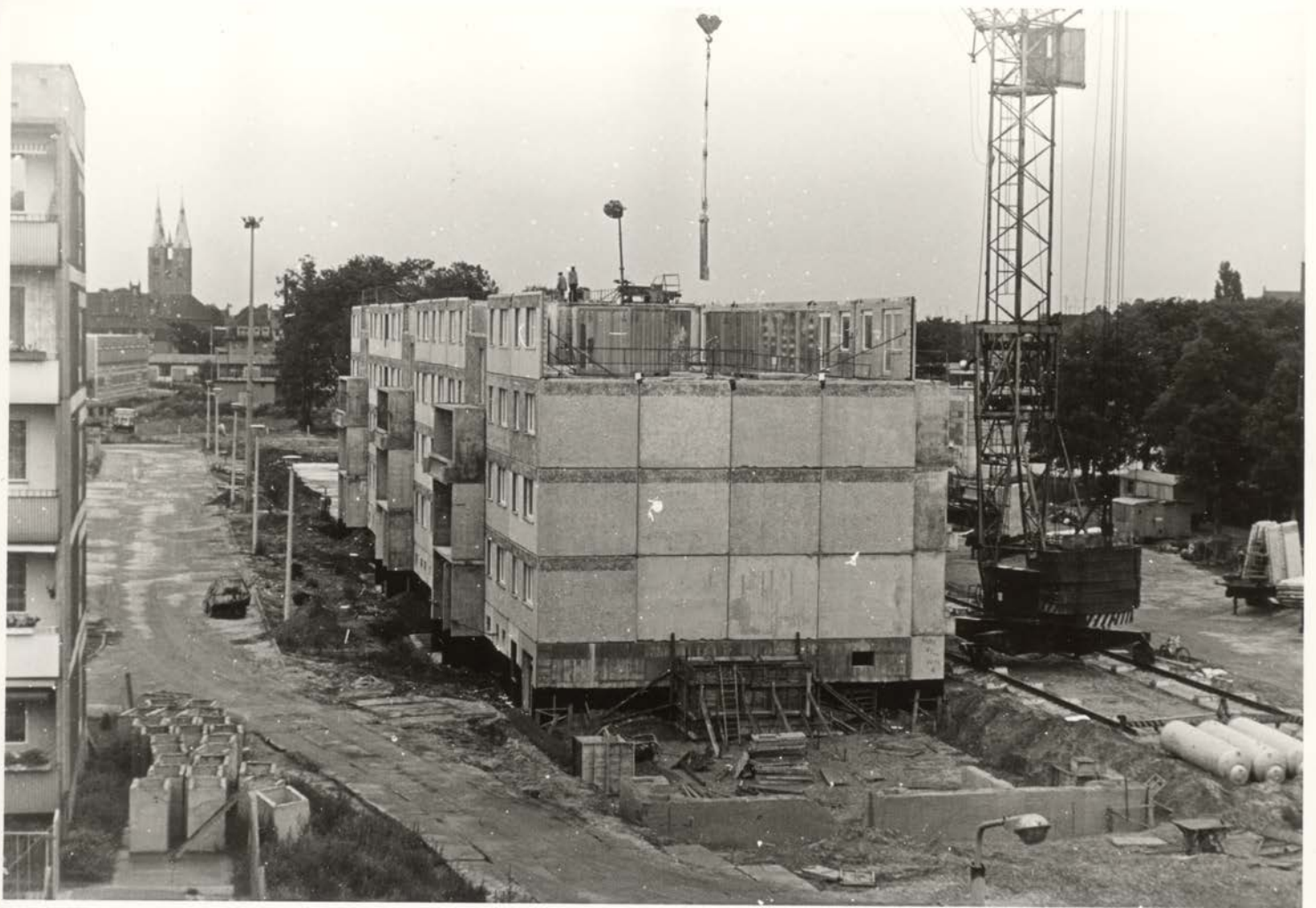
Baustelle Wohngebiet Stadtsee, bezeichnet: 4.7. 80; Foto: K. Heiden
