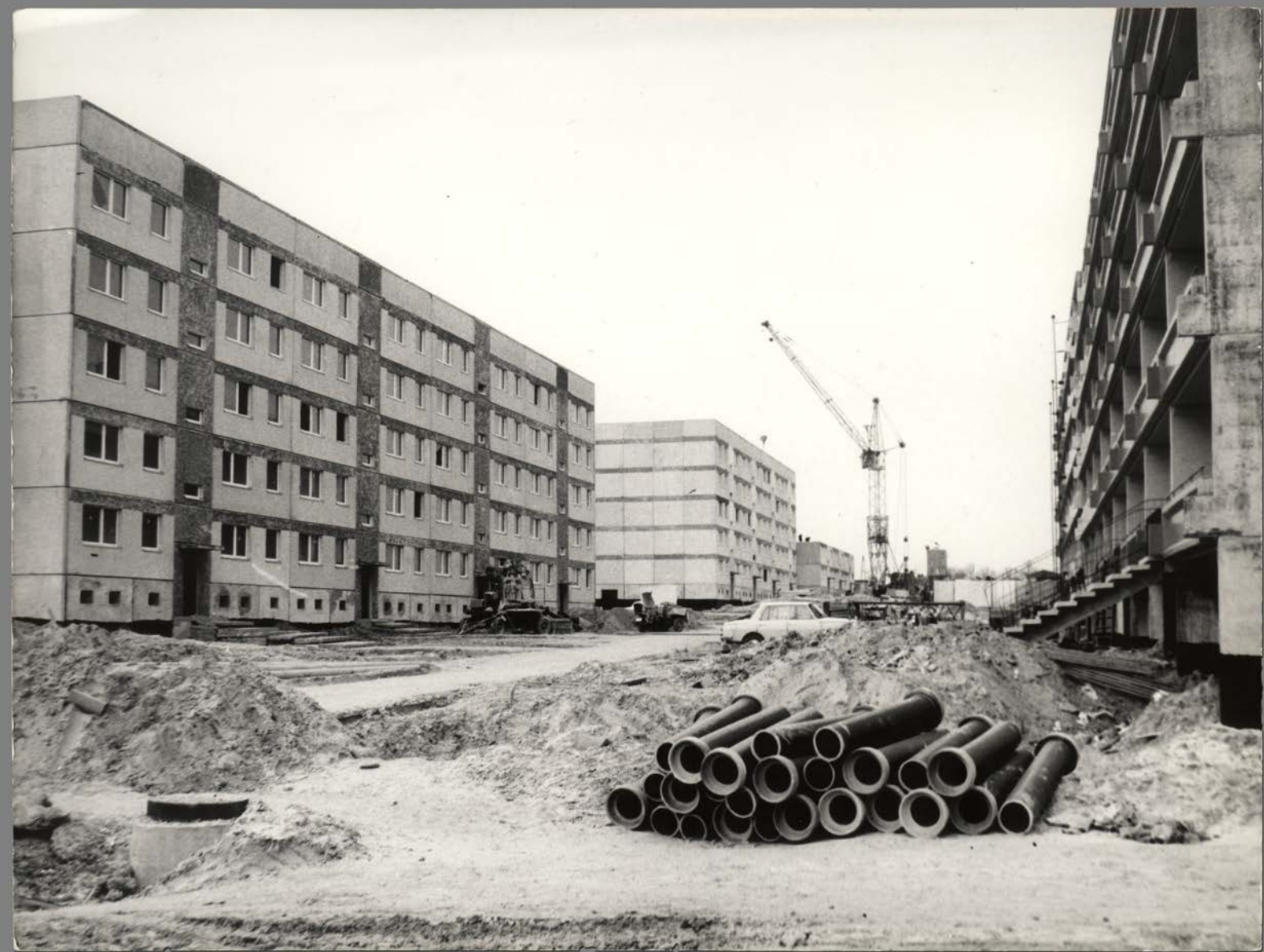
Wohngebiet Stadtsee im Bau
